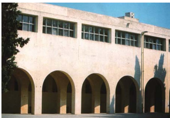
Fig.5 : Bâtiment administratif. Au nord galerie et couloir à l'étage protègent des rigueurs de l'hiver
